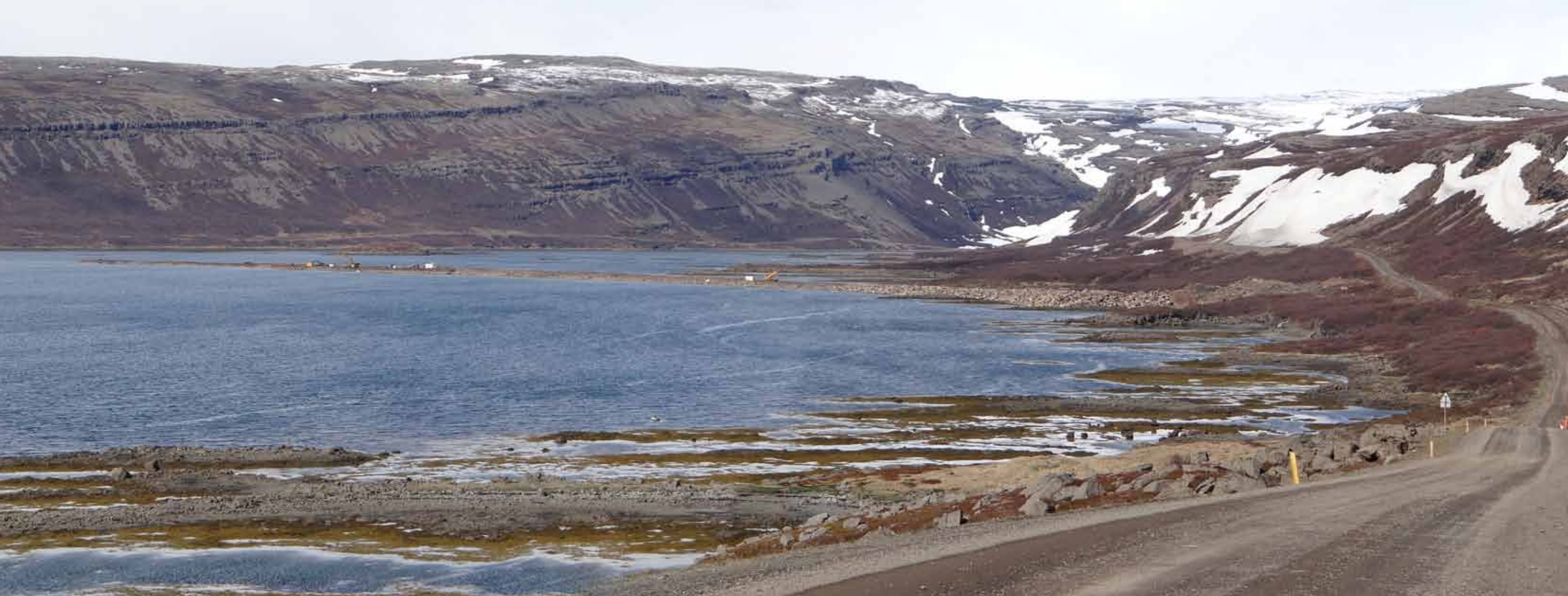
Fylling út í Kjálkafjörð. Bedið er með framhaldið þar til brúargerðinni er lokið. Brúarstæðið er þar sem tækin standa á fyllingunni. Sjá myndir í næstu opnu. Gamla veginn má sjá til hægri á myndinni. Það verður lítil eftirsjá af honum.
